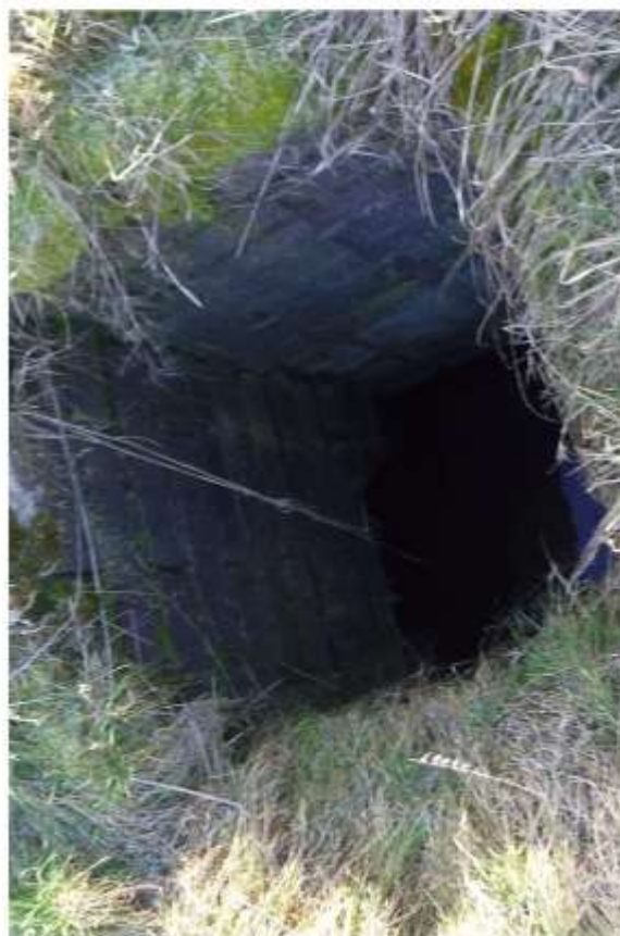
ŠACHTA - DÁLE VODOTEČ POKRAČUJE JAKO ZATRUBNĚNÁ
